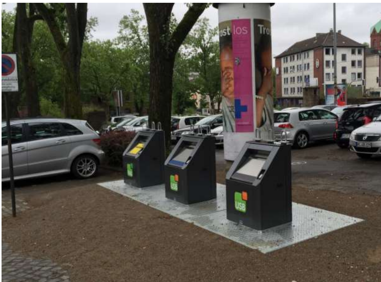
Das Unterflursystem erreicht eine deutliche Platzeinsparung durch den Wegfall von sperrigen Abfallgroßbehältern. (11)
