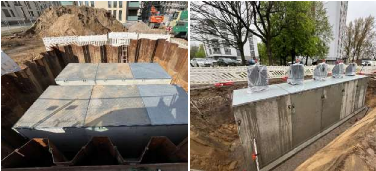
Aushub der Baugrube mit Verbau (links) und Einlass der Betonschächte in die Baugrube ohne Verbau (rechts). (c)
