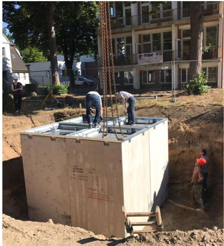
*Aushub der Baugrube mit Verbau (links) und Einlass der Betonschächte in die Baugrube ohne Verbau (rechts). <sup>(5)</sup>*
