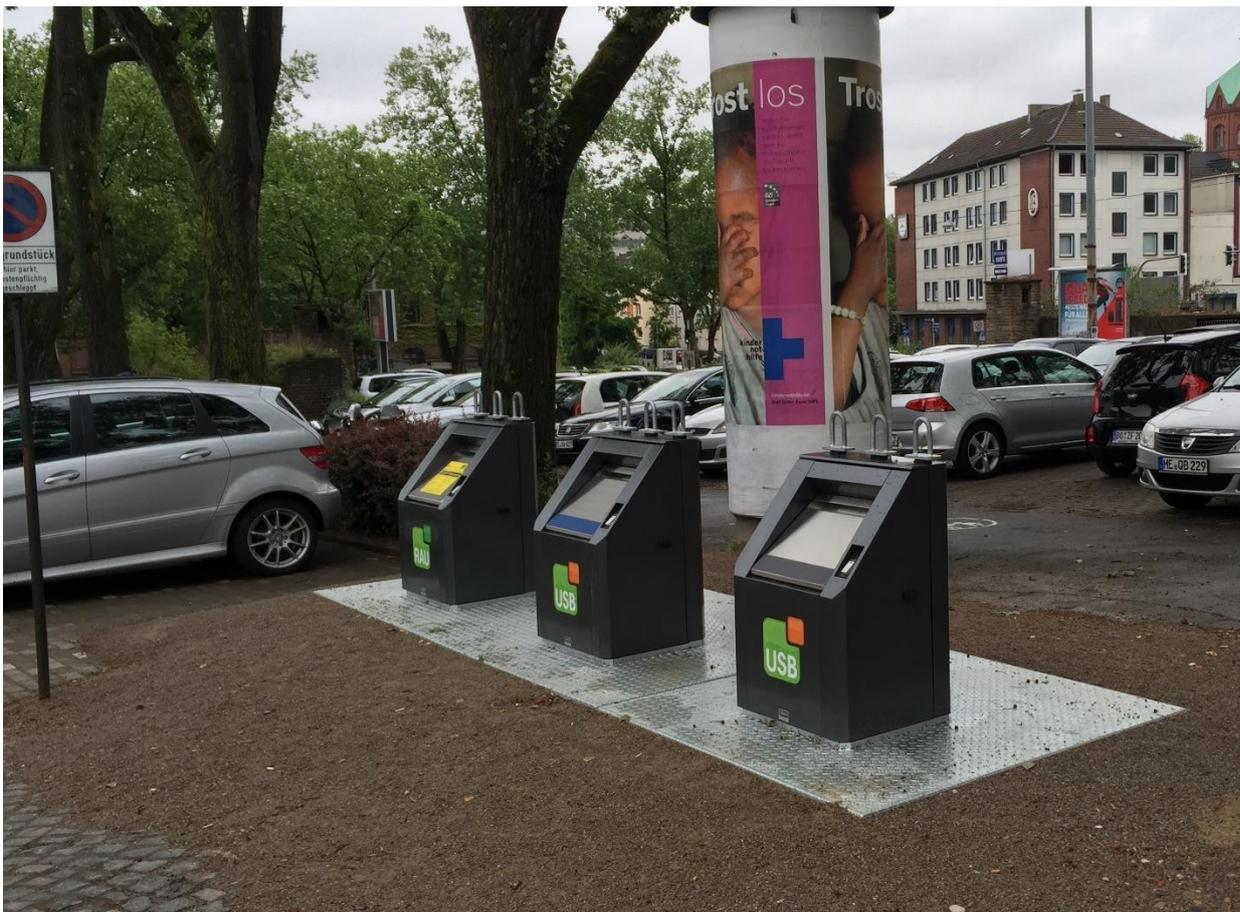
Das Unterflursystem erreicht eine deutliche Platzeinsparung durch den Wegfall von sperrigen Abfallgroßbehältern. <sup>(14)</sup>
